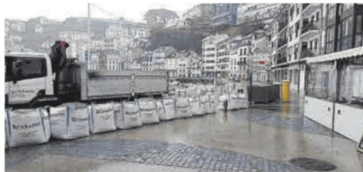
Muro de contención instalado en Luarca para frenar el oleaje.
